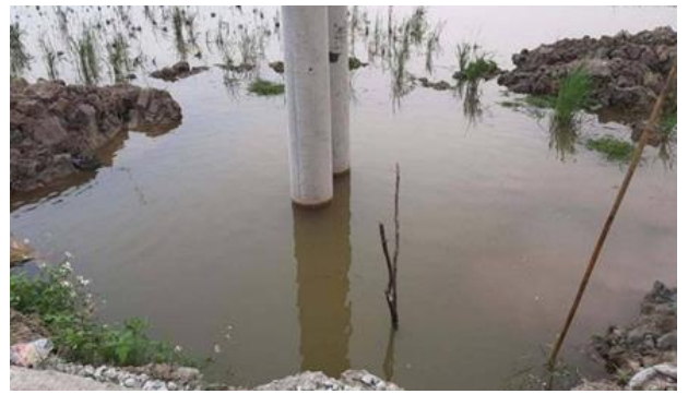
Cống thoát nước công cộng không có nắp đậy, hồ chôn cột điện không lấp
